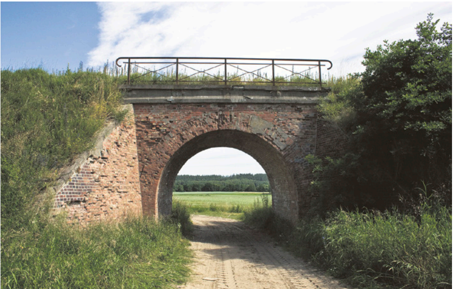
[42b] Wiadukt kolejowy nad polną drogą w okolicach Niestępowa i Starej Piły. Zachowane barierki świadczą o tym, iż w te rejony nie dotarli jeszcze zbieracze złomu. Widok od strony południowej. 8.07.2010 r.
