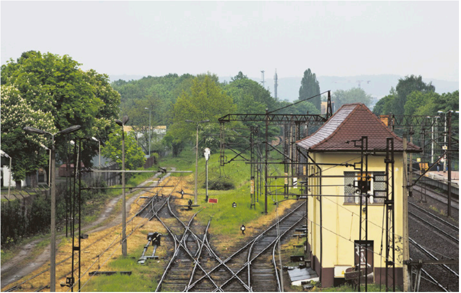
[1] Widok na początek nasypu linii Wrzeszcz – Stara Piła (w centrum zdjęcia) z wiaduktu w ciągu ul. Braci Lewoniewskich. 21.05.2011 r.
