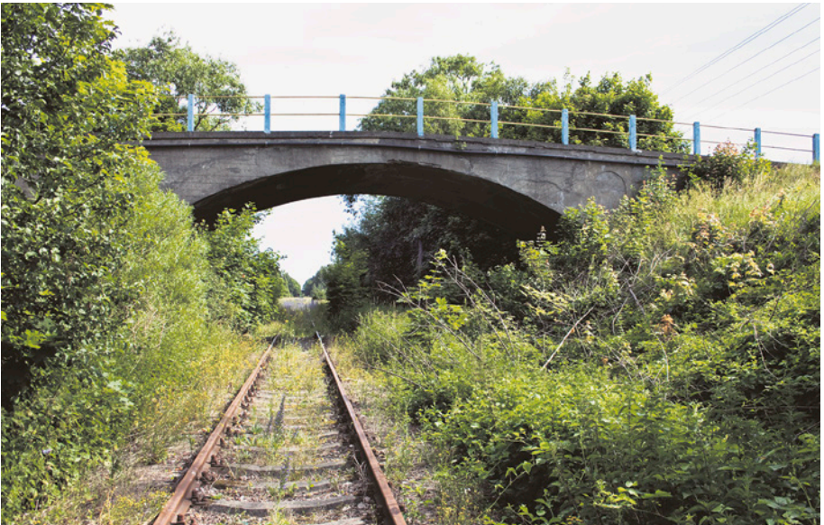
[38b] Wiadukt drogi łączącej Leżno ze Smęgorzynem i Kiełpinem. Pod wiaduktem miejsce na drugi tor oraz kolejowa linia telegraficzna. Widok od strony południowej w kierunku Leżna. 8.07.2010 r.
