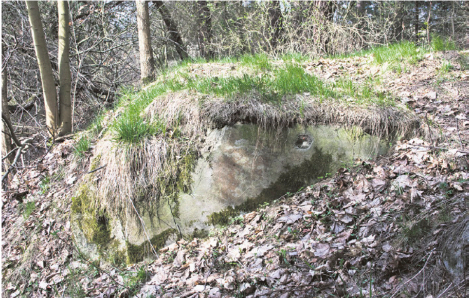
[22a] Pozostałości północnego przyczółka wiaduktu w ciągu drogi z Migowa do Nowca. Widok od strony wschodniej. 28.04.2010 r.
