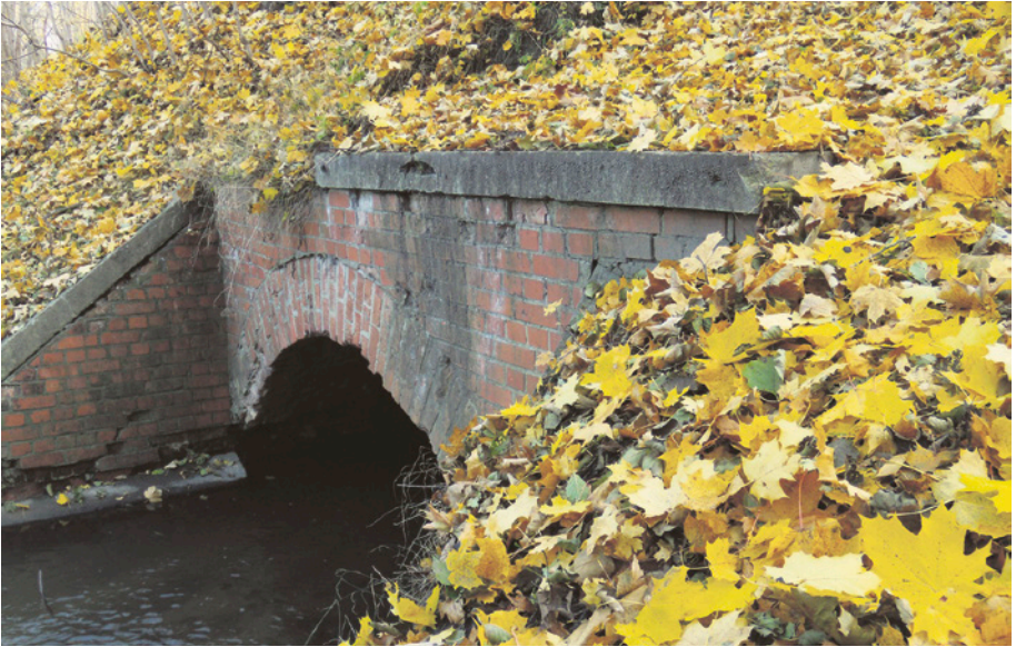
[11a] Przepust potoku Strzyży pod nasypem kolei Wrzeszcz – Stara Piła w Brętowie. Widok od strony zachodniej. 3.11.2009 r.
