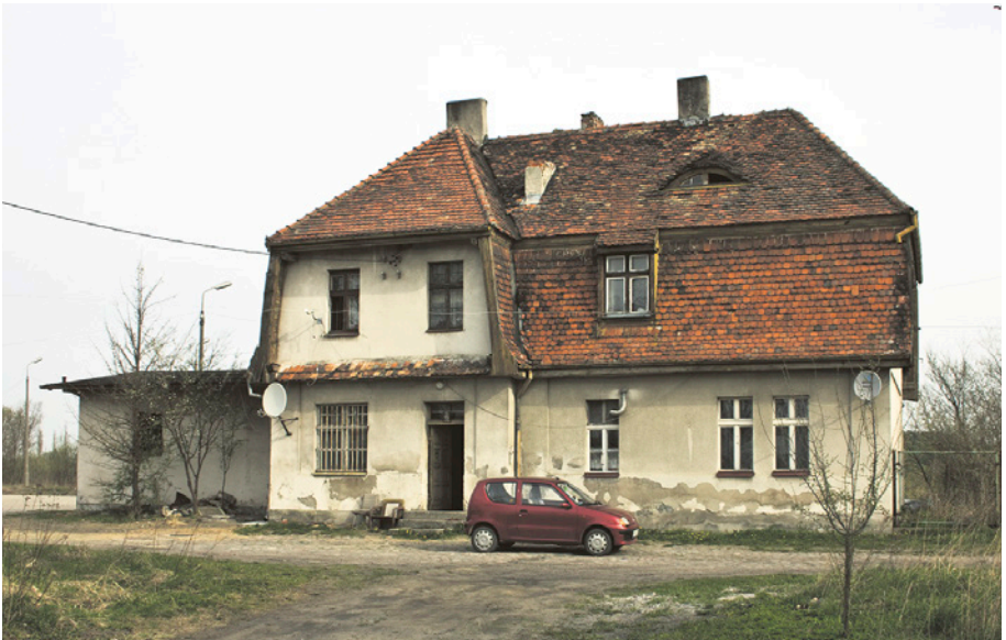
[33b] Budynek stacji w Kokoszkach przy dzisiejszej ul. Maszynowej podobnie jak ten w Kietpinku pełni już tylko funkcje mieszkalne. Widok od strony południowej. 30.04.2010 r.
