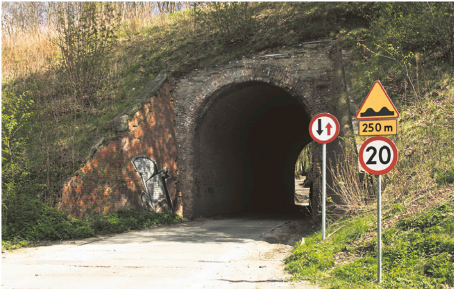
[14a] Wiadukt nad ul. Ogrodową. Widok od strony zachodniej w kierunku Wrzeszcza. Przez amatorów wspinaczki nazywany jest Elektrycznym. 5.05.2010 r. FOT. HENRYK JURSZ
