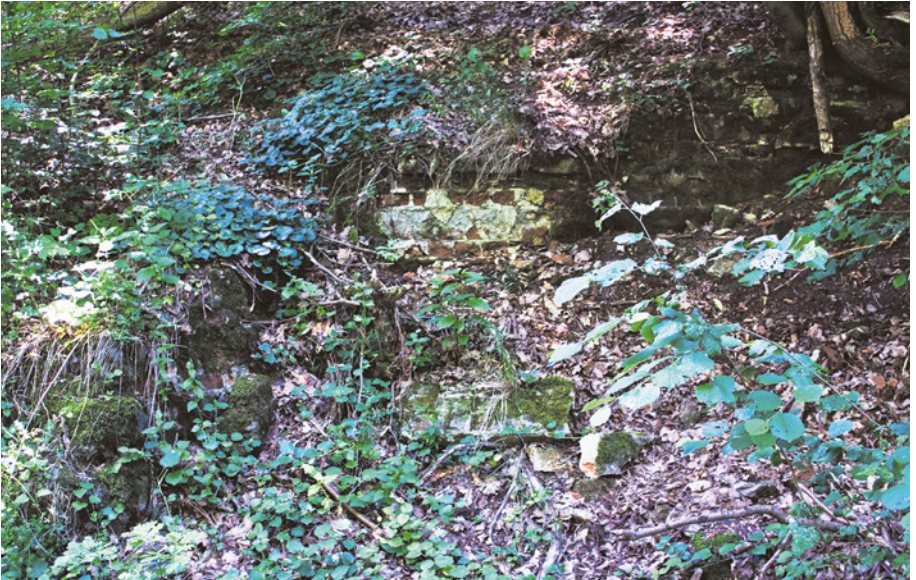
[45] Pozostałości północnego przyczółka wiaduktu za stacją w Starej Pile zniszczonego w 1939 r. w pierwszych dniach września. 8.07.2010 r.
