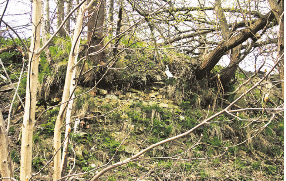
[30b] Południowy przyczółek zniszczonego w 1945 r. wiaduktu drogowego w ciągu dzisiejszych ulic Dojazdowej i Osiedlowej to tylko sterta zarośniętych cegieł. 30.04.2010 r.
