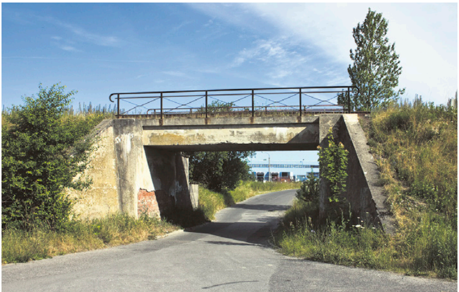
[34b] Wiadukt kolejowy przy ul. Maszynowej. Od czasu do czasu jeszcze jeżdżą po nim pociągi towarowe do zakładów w Kokoszkach. Widok od strony południowej. 8.07.2010 r.
