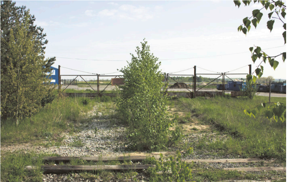
Dawna bocznica do Gdańskiego Przedsiębiorstwa Robót Drogowych w Matarni dziś dostawnie urywa się przed bramą terenu lotniska. 20.05.2010 r.
