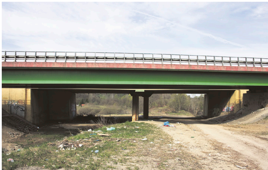
[28a] Wiadukt nad torem w Karczemkach zbudowano wraz z obwodnicą Trójmiasta pod koniec lat 70. xx w. Widok od strony wschodniej. 30.04.2010 r. FOT. HENRYK JURSZ
