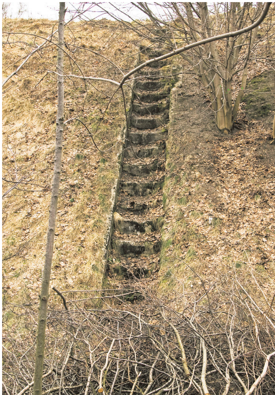
[13] Kaskada na skarpie wykopu kolejowego między drogą z Brętowa do Srebrzyska a ul. Ogrodową. Widok od strony zachodniej. 10.02.2011 r.
