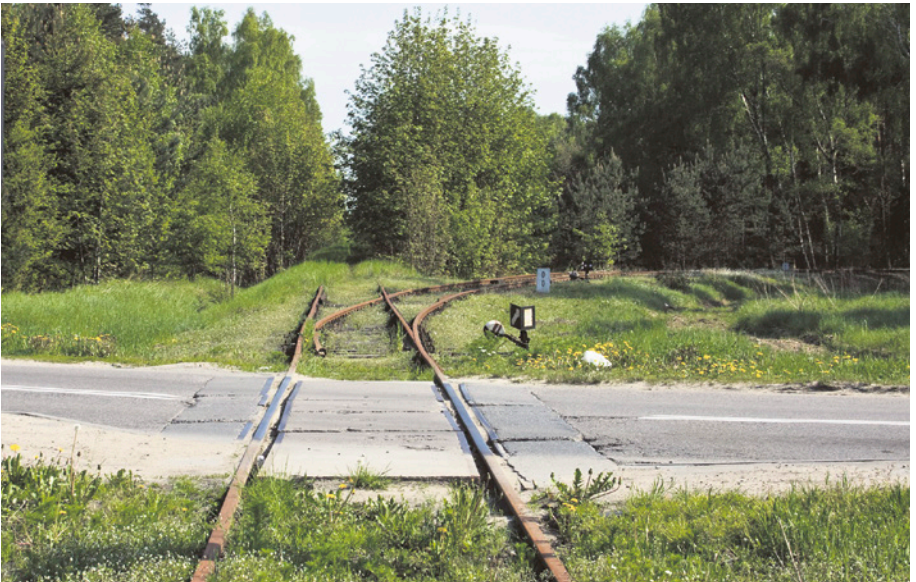
Przejazd drogowy w ciągu ul. Słowackiego w Firodzie przed przebudową. Na wprost dawna bocznica Gdańskiego Przedsiębiorstwa Robót Drogowych w Matarni, na prawo tor bocznicy paliwowej portu lotniczego. 20.05.2010 r.
