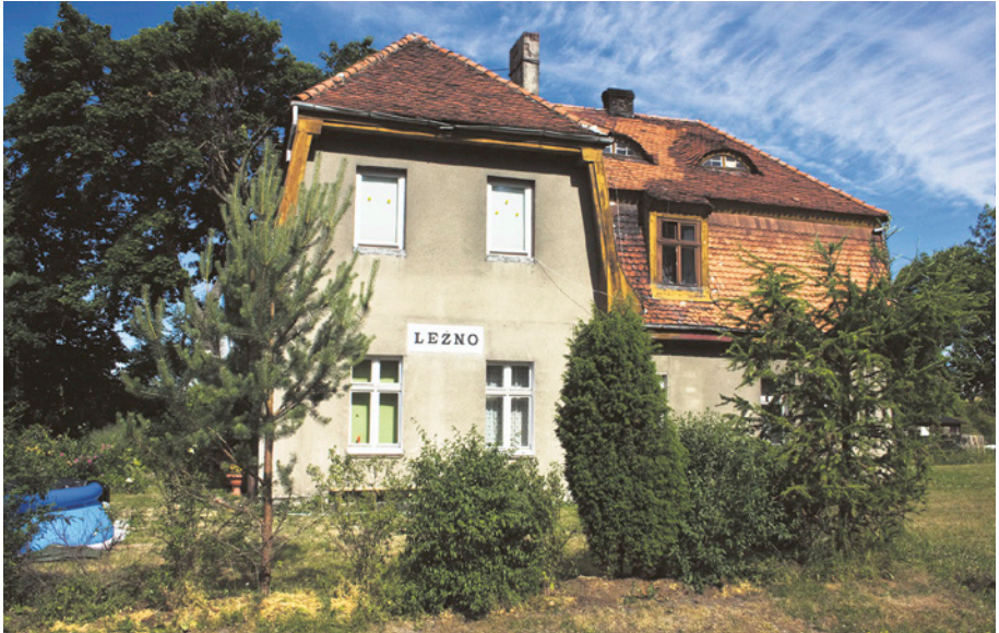
[37a] Budynek stacji w Leźnie, choć pełni funkcje mieszkalne, nic nie stracił ze swojego kolejowego charakteru. Widok od strony północnej. 8.07.2010 r. FOT. HENRYK JURSZ
