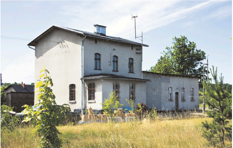
[44a] Budynek mieszkalny na stacji Stara Piła. Pod krawędzią dachu słabo widoczny ślad nazwy. Widok od strony północnej. 8.07.2010 r.
