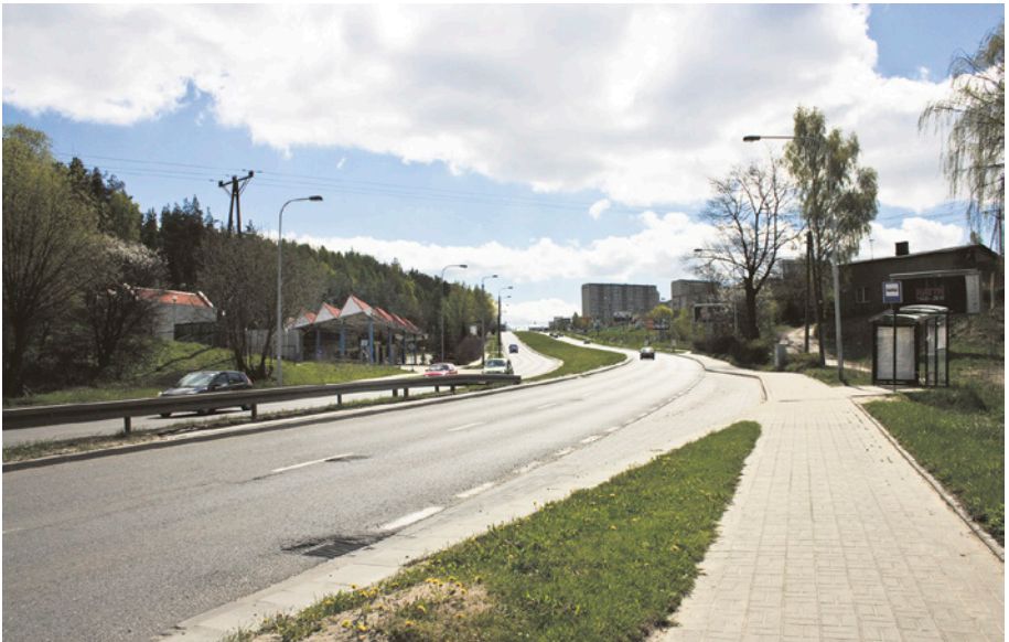
[17] Budowa szerokiej ul. Rakoczego wymusiła wyburzenie pod koniec lat 70. xx w. istniejącego w tym miejscu wiaduktu kolejowego o konstrukcji podobnej do tego nad ul. Ogrodową. Widok w kierunku południowym. 5.05.2010 r. FOT. HENRYK JURSZ
