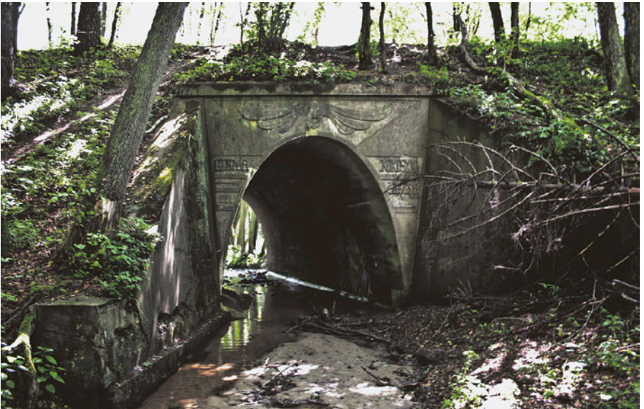
Przepust potoku Kacza w okolicy Krykulca w Gdyni. Na nim do 1930 r. przejeżdżały pociągi linii Kokoszki – Gdynia w jej przebiegu z 1921 r. Widok od strony północnej. 14.07.2010 r.
