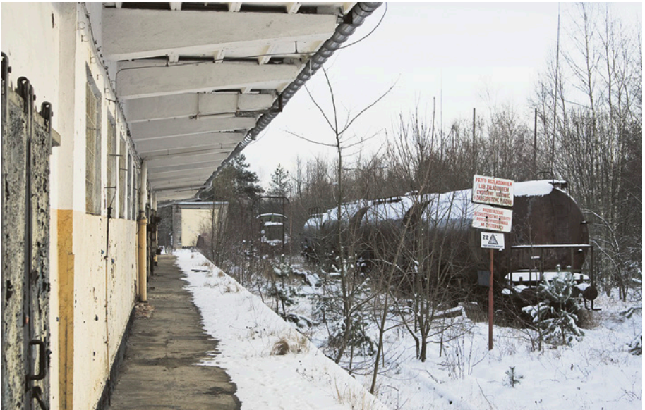
[26b] W odciętej od bocznic CPN bazie magazynowej w Kietpinku na torach pozostały wagony cysterny i lokomotywa manewrowa SM30-602. Budynki bazy według ewidencji PKN Orlen ukończone zostały w 1961 r. 17.01.2012 r.
