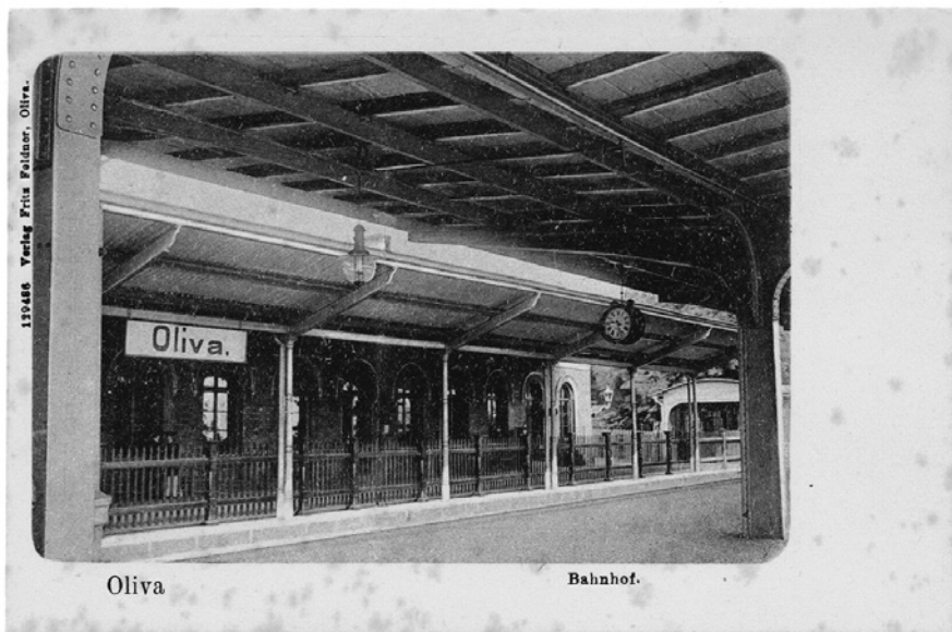
Widok spod peronowej wiaty na budynek dworca w Oliwie. Widoczna także wiata nad zejściem do tunelu prowadzącego na peron. Poczтівka bez obiegu, najprawdopodobniej sprzed 1926 r.
