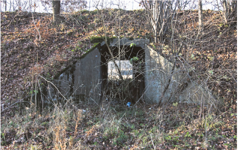
[31a] Przepust wąskotorowej kolejki cegielnianej z 1921 r. w Kokoszkach pod linią Kokoszki – Gdynia. Widok od strony zachodniej. 23.11.2011 r.
