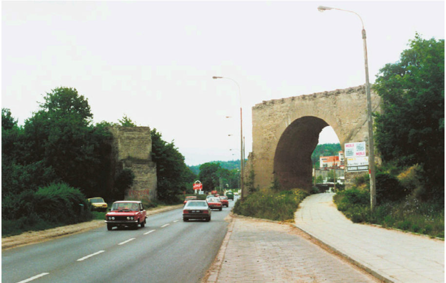
Przyczółki zniszczonego w 1945 r. wiaduktu kolejowego nad ul. Słowackiego. Widok w kierunku Brętowa i Niedźwiednika. 4.07.1993 r.
