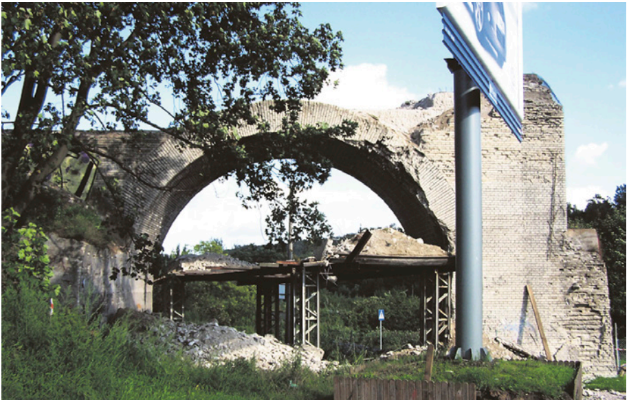
Rozbiórka północnego przyczółka zniszczonego wiaduktu kolejowego nad ul. Słowackiego związana była z budową Trasy Słowackiego. Widok w kierunku Wrzeszcza. Sierpień 2006 r.
