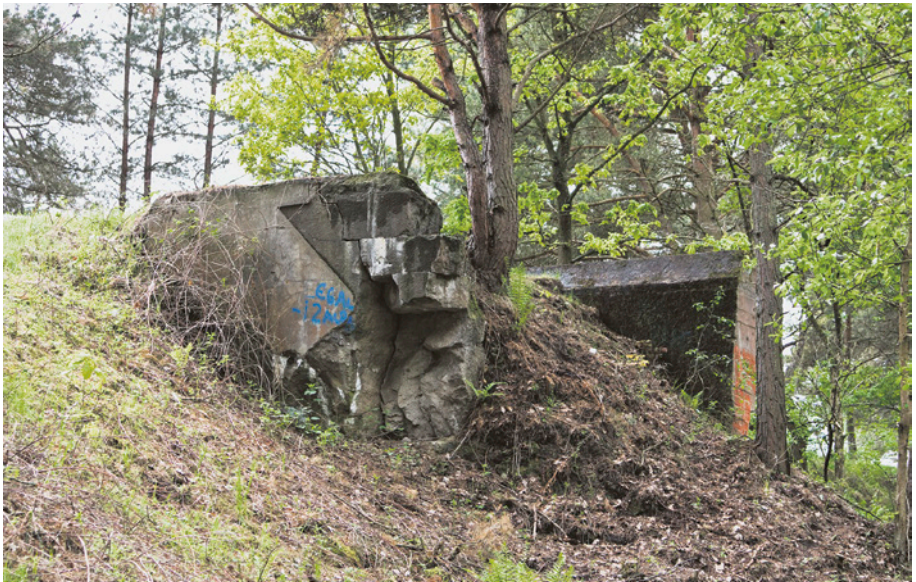
[22b] W lepszym stanie zachowały się pozostałości południowego przyczółka wiaduktu nad torowiskiem w ciągu drogi z Migowa do Nowca. Widok od strony wschodniej. 21.05.2011 r.
