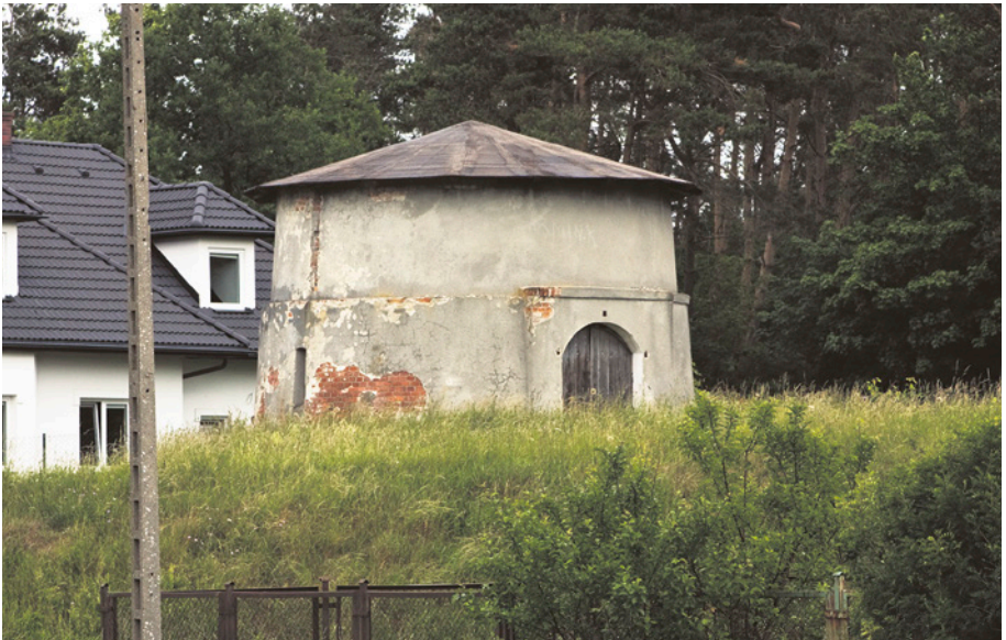
[44b] Niemal naprzeciwko stacyjnego budynku mieszkalnego na małym wzniesieniu zachowała się jeszcze niewielka wieża wodna wybudowana wraz z linią Wrzeszcz – Stara Piła. 24.06.2011 r.
