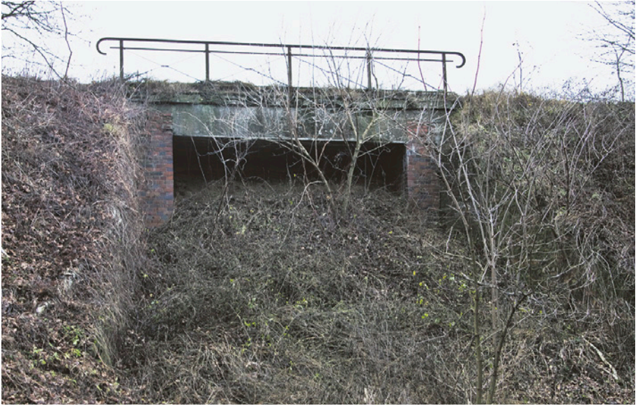
[39a] Wiadukt kolejowy nad polną drogą tuż przed mostem nad rzeką Radunią. Widok od strony zachodniej. 20.12.2011 r.
