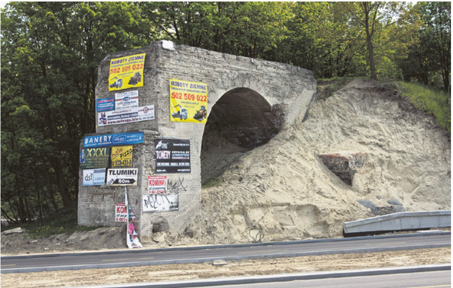
[10b] Podczas prac związanych z budową Trasy Słowackiego przy zachowanym południowym przyczółku odstępiono fundament drugiego niewybudowanego wiaduktu kolejowego. 20.05.2012 r.
