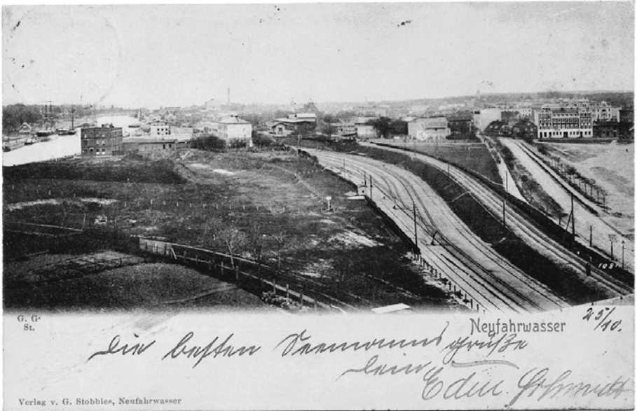
Widok na tory do obsługi portu wolnoctowego i nabrzeży portowych oraz tor kolei podmiejskiej (po prawej na nasypie) w Nowym Porcie. Pocztkówka wystana w październiku 1900 r.
