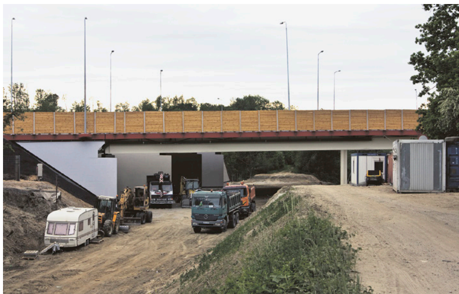
[28b] Rozbudowa węzła Karczemki objęta również wiadukt obwodnicy Trójmiasta nad przyszłą linią PKM, dawną Wrzeszcz – Stara Piła. Widok od strony wschodniej. 26.05.2012 r. FOT. HENRYK JURSZ
