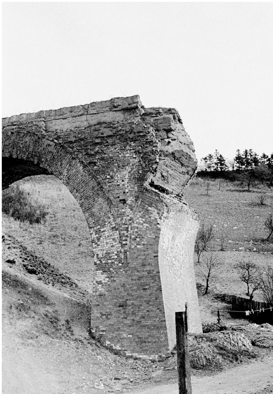
Wschodni przyczółek łukowego wiaduktu kolejowego nad ul. Dolne Migowo. Widok od strony północnej. 1973 r.
