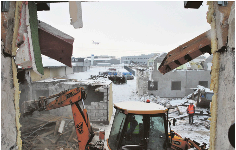
Wyburzenia zabudowań w Matarni przy ul. Sądzińskiej były przygotowaniem terenu pod budowę nowego, przebiegiem nawiązującego do projektów z początku XX w., odcinka przyszłej trasy PKM. 21.01.2013 r. FOT. TOMASZ KONOPACKI/PKM
