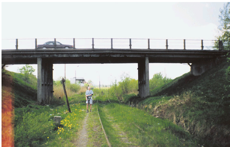
Wiadukt w ciągu ul. Nowatorów przed remontem rozpoczętym w 2003 r. Widoczny tor linii Kokoszki – Gdynia. Widok w kierunku zachodnim na równię stacji w Kokoszkach. Wiosna 2003 r.
