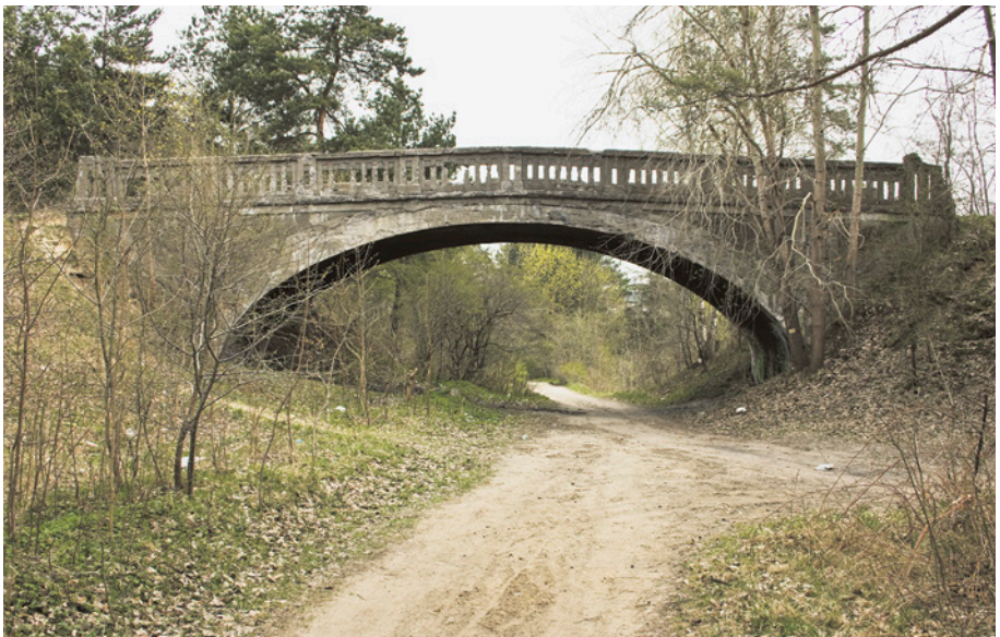
[20b] Kładka nad dawnym torowiskiem w okolicy Migowa pierwotnie łączyła prywatne grunty. Po 1945 r. przechodzili pod nią żołnierze Niebieskich Beretów w drodze z i na poligon. Widok od strony zachodniej. 30.04.2010 r.
