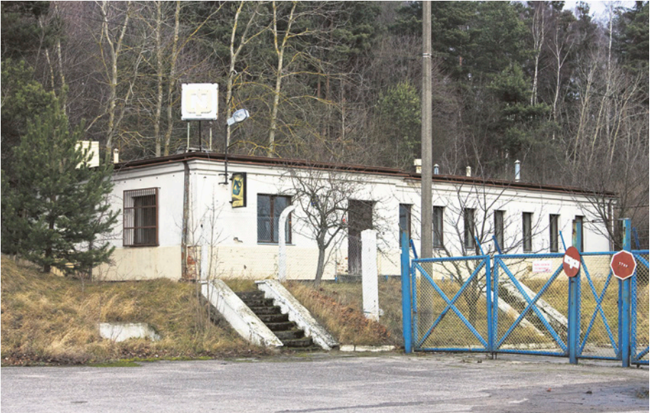
[26a] Zabudowania bazy PKN Orlen, niegdyś CPN, architekturą przypominają pierwsze budynki SKM. 20.12.2011 r.
