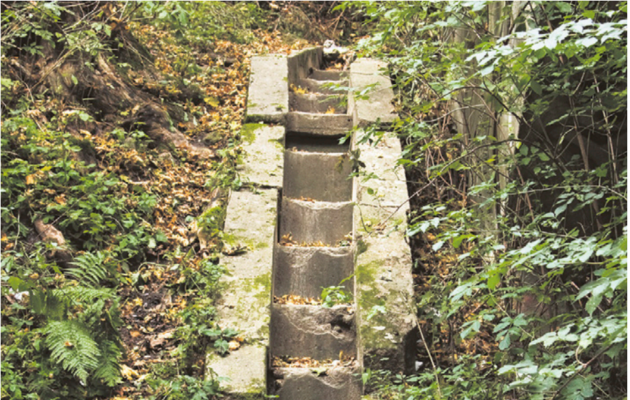
[8c] Kaskada odwodnienia przy wiadukcie nad dawnym torowiskiem w przedłużeniu ul. Ludowej. Widok od strony południowo-zachodniej. 08.10.2010 r. FOT. HENRYK JURSZ
