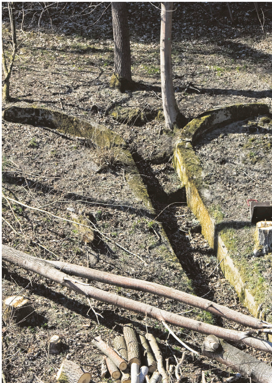
[19] Kaskada odwodnienia w okolicy Migowa odprowadzająca wodę deszczową ze wzgórza do rowu odwadniającego u stóp nasypu kolejowego. Dopiero wycinka drzew przed budową PKM wyraźnie ją odstoniła. 21.04.2013 r.
