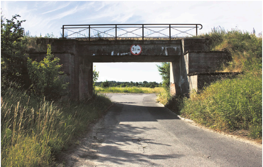
[34a] Wiadukt kolejowy przy ul. Maszynowej nad drogą łączącą ulice Maszynową i Budowlanych. Widok od strony północnej. 8.07.2010 r.
