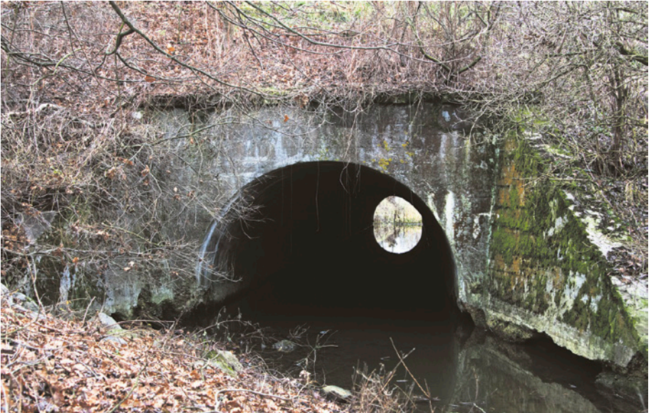
[40] Przepust starej Raduni w pobliżu mostu kolejowego nad rzeką Radunią. Widok od strony zachodniej. 20.12.2011 r.
