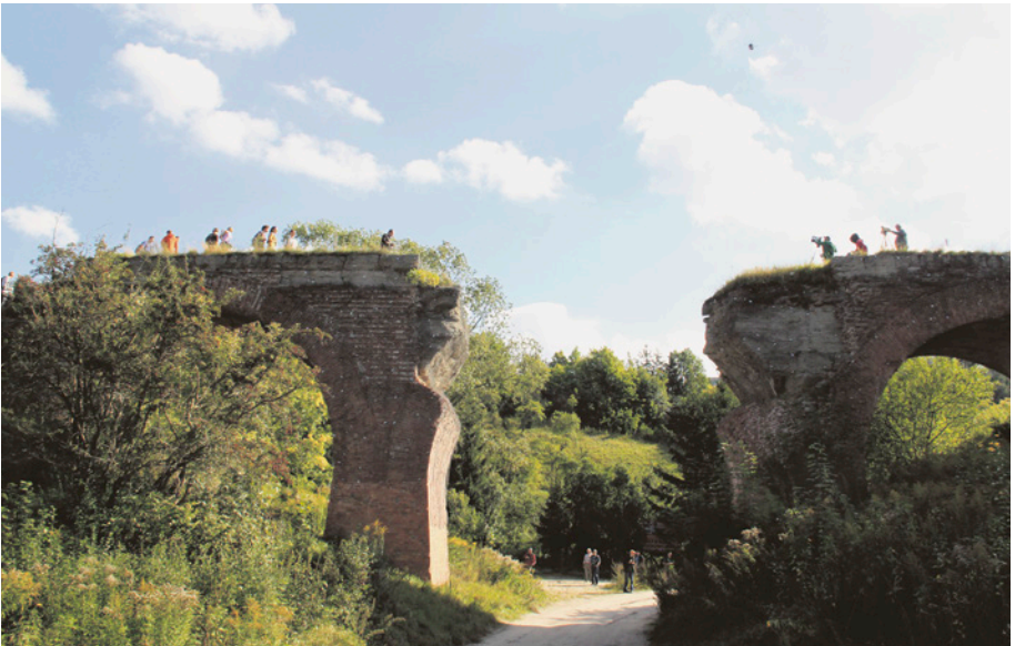
Dzięki spacerom szlakiem kolei z Wrzeszcza do Kokoszek powstało wiele unikalnych fotografii dokumentujących stan stuletnich wiaduktów w ostatnich latach ich istnienia. Wiadukt nad ul. Dolne Migowo. 29.09.2012 r. FOT. TOMASZ KONOPACKI/PKM
