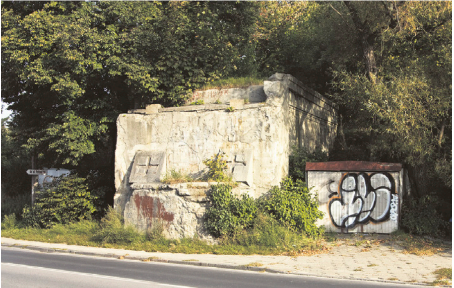
[5a] Wschodni przyczółek wiaduktu nad ul. Polanki. Widok od strony południowo-zachodniej. 8.10.2010 r.
