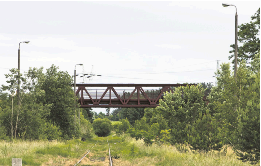
[43b] Wiadukt po wschodniej stronie stacji Stara Piła w ciągu ul. Raduńskiej – drogi łączącej Niestępowo i Lniska. Widok od strony zachodniej w kierunku Niestępowo. 24.06.2011 r. FOT. HENRYK JURSZ
