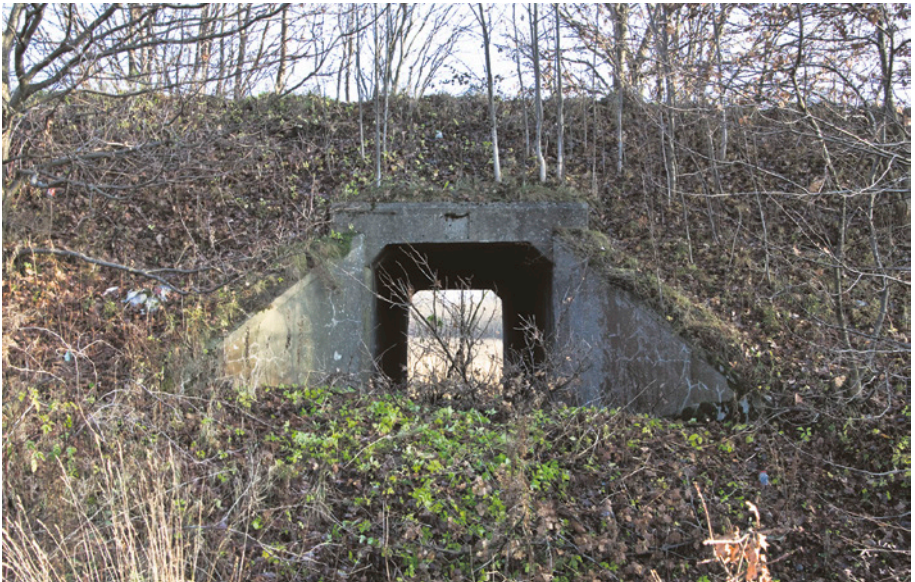
[31b] Przepust wąskotorowej kolejki cegielnianej z 1921 r. w Kokoszkach pod linią Kokoszki – Gdynia. Tak jak na nasypie, tak i w przepuście brak śladu po torach. Widok od strony wschodniej. 23.11.2011 r.
