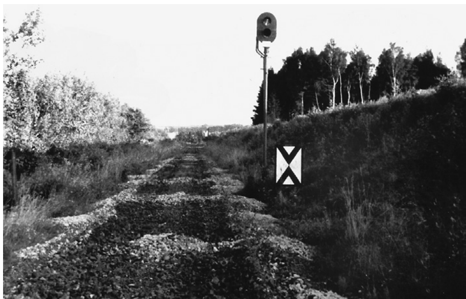
Wkrótce po zawieszeniu ruchu pociągów z Osowej do Kokoszek, na odcinku przeznaczonym pod budowę nowego lotniska zdemontowano nawierzchnię kolejową. Klukowo – Kokoszki. 9.09.1973 r.
