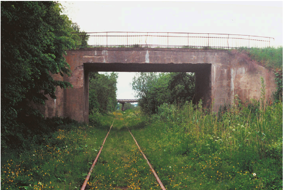
Wiadukt drogowy w ciągu ul. Szczęśliwej w Kiełpinku. Widok w kierunku zachodnim w stronę stacji w Kokoszkach. 3.06.1994 r.
