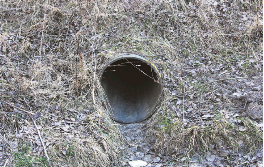
[23] Przepust rurowy kilka metrów na zachód od wielkiej przerwy w nasypie, w której obecnie płynie strumień. Widok od strony północnej. 7.03.2012 r. FOT. HENRYK JURSZ
