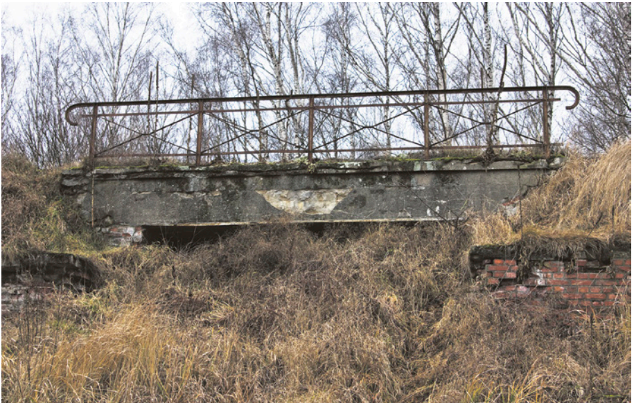
[39b] Wiadukt kolejowy nad polną drogą tuż przed mostem nad rzeką Radunią. Z nieznanых powodów możliwość przejazdu pod nim zlikwidowano ok. 2006 r. Widok od strony wschodniej. 20.12.2011 r.
