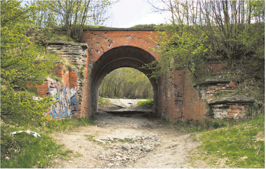
[15a] Drugi wiadukt przy ul. Ogrodowej. Widok od strony zachodniej. Nazywany bywa wiaduktem Gdyńskim. 5.05.2010 r.
