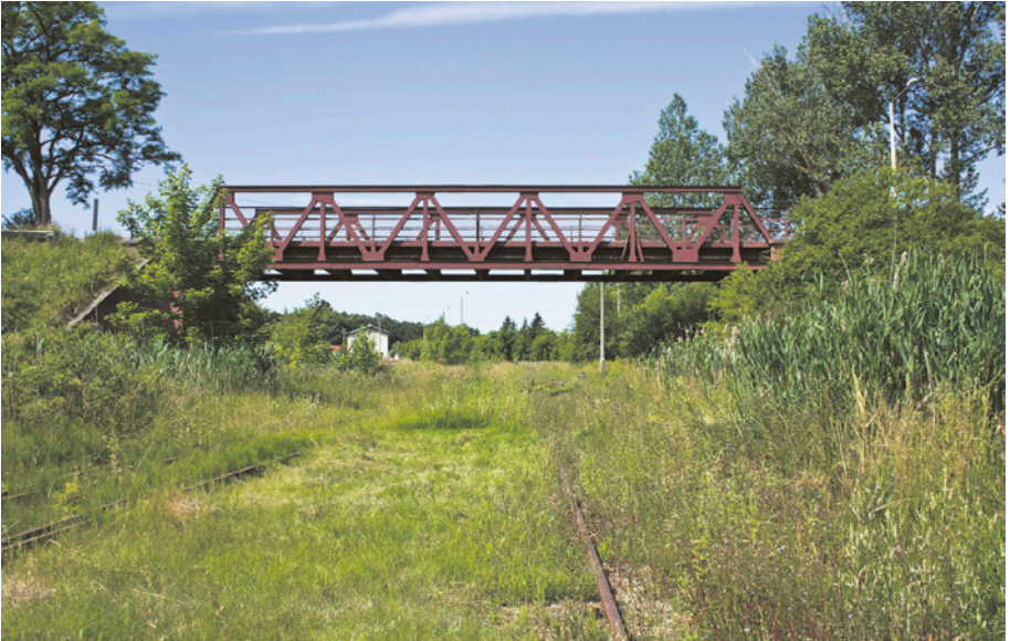
[43a] Wiadukt po wschodniej stronie stacji Stara Piła w ciągu ul. Raduńskiej – drogi łączącej Niestępowo i Lniska. Widok od strony wschodniej. 8.07.2010 r. FOT. HENRYK JURSZ
