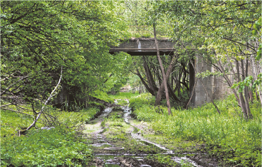
[27a] Wiadukt ul. Szczęśliwej nad dawnym torowiskiem niedługo po fizycznej likwidacji toru bocznicy CPN. Widok od strony wschodniej. 21.05.2011 r. FOT. HENRYK JURSZ
