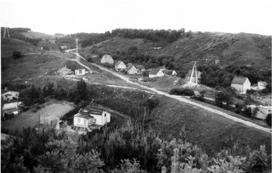
Widok na nasyp ze wzgórza nad dzisiejszą ul. Rakoczego w kierunku zachodnim w ujęciu bardzo zbliżonym do powyższego. Fragment nasypu w prawym dolnym rogu został później rozebrany. Lato 1977 r.
