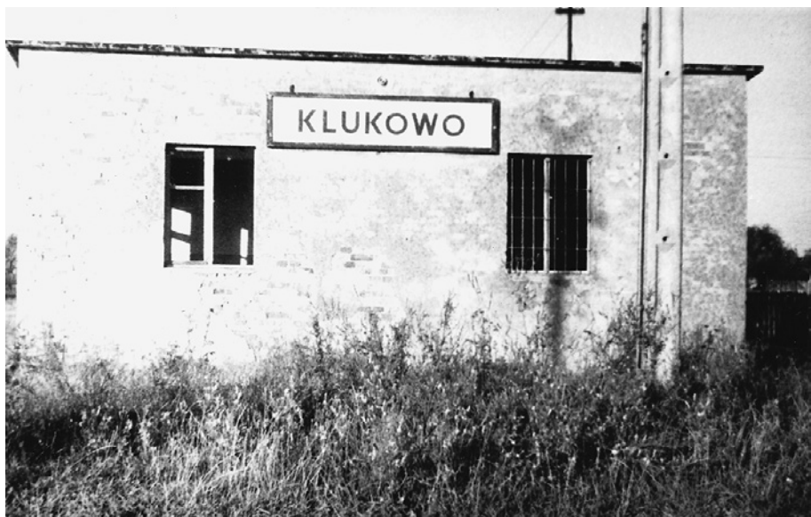
Wybudowana w 1960 r. poczekalnia dla podróżnych na przystanku Klukowo, którego krawędź peronową wykonano z używanych podkładów. 9.09.1973 r. FOT. ROMAN WITKOWSKI
